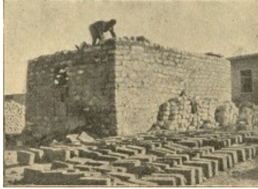
Et af husene under opførelse -beboerne er alle selvbyggere,
